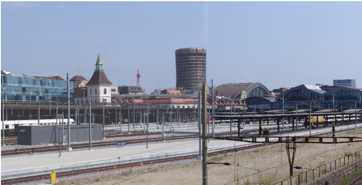
Ist-Zustand Gleisanlagen Bahnhof SBB - zukünftiges Areal des CentralParkBasel
